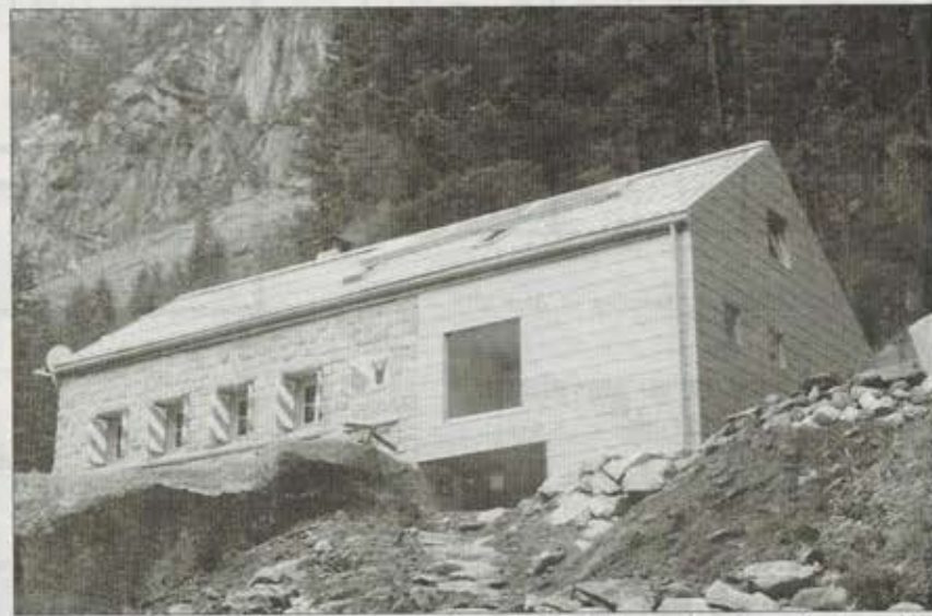
Die Treschhütte erhielt ein neues Doppelfalzdach sowie einen Anbau. Die Spenglerarbeiten wurden von der Spenglerei Mario Tresch GmbH ausgeführt.
