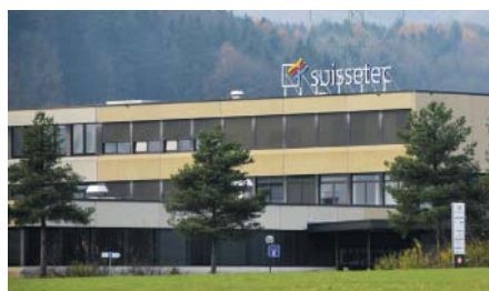
Neue Leuchtreklame auf dem Dach des suissetec-Bildungszentrums Lostorf.
